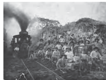
鉄道敷設工事に従事する移民の皆さん
